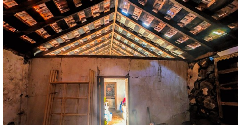
Kanarisches Gebäude mit originalem Tea-Holzboden in La Punta auf La Palma.
